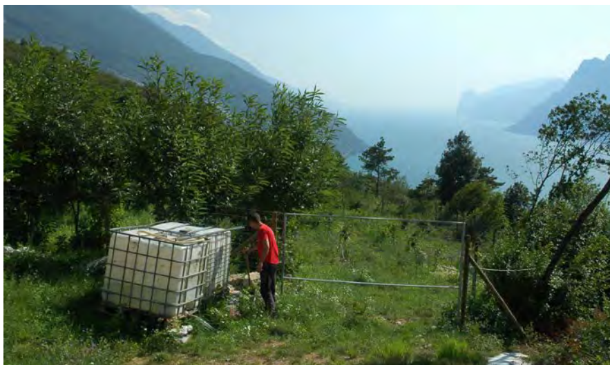
L'area a lavori ultimati (completamente recintata)
