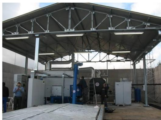
Centrale di cogenerazione a biomassa in filiera corta (potenza 500 kWt-100 kWe) nel Lazio
