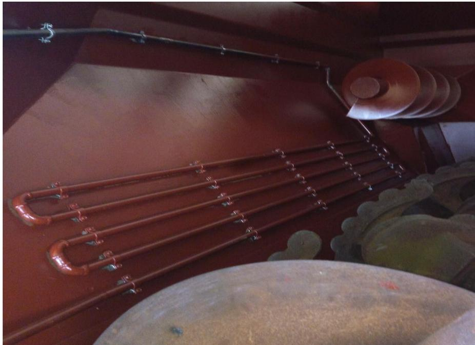
**Figura 8. Posa in opera del sistema di riscaldamento interno**
