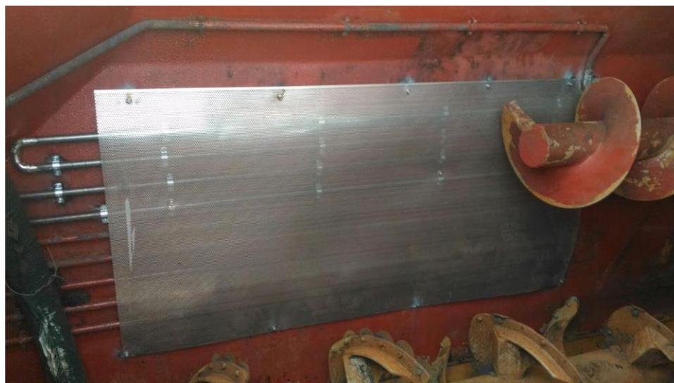
**Figura 12. Intervento per ridurre il coefficiente di sporcamento della serpentina di riscaldamento**
